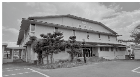
▲御船小学校体育館
