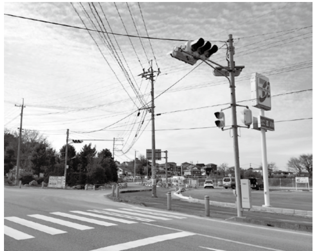
改良工事が進む小敷田西往還線
