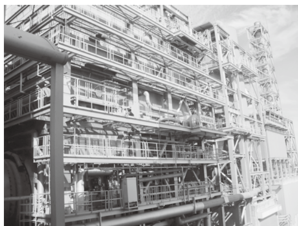
三重県にある焼却施設の様子
