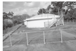
高木第一配水
