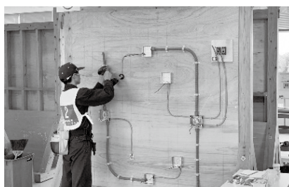
電気工事部門の様子
