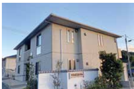
△災害公営住宅（木倉団地）
