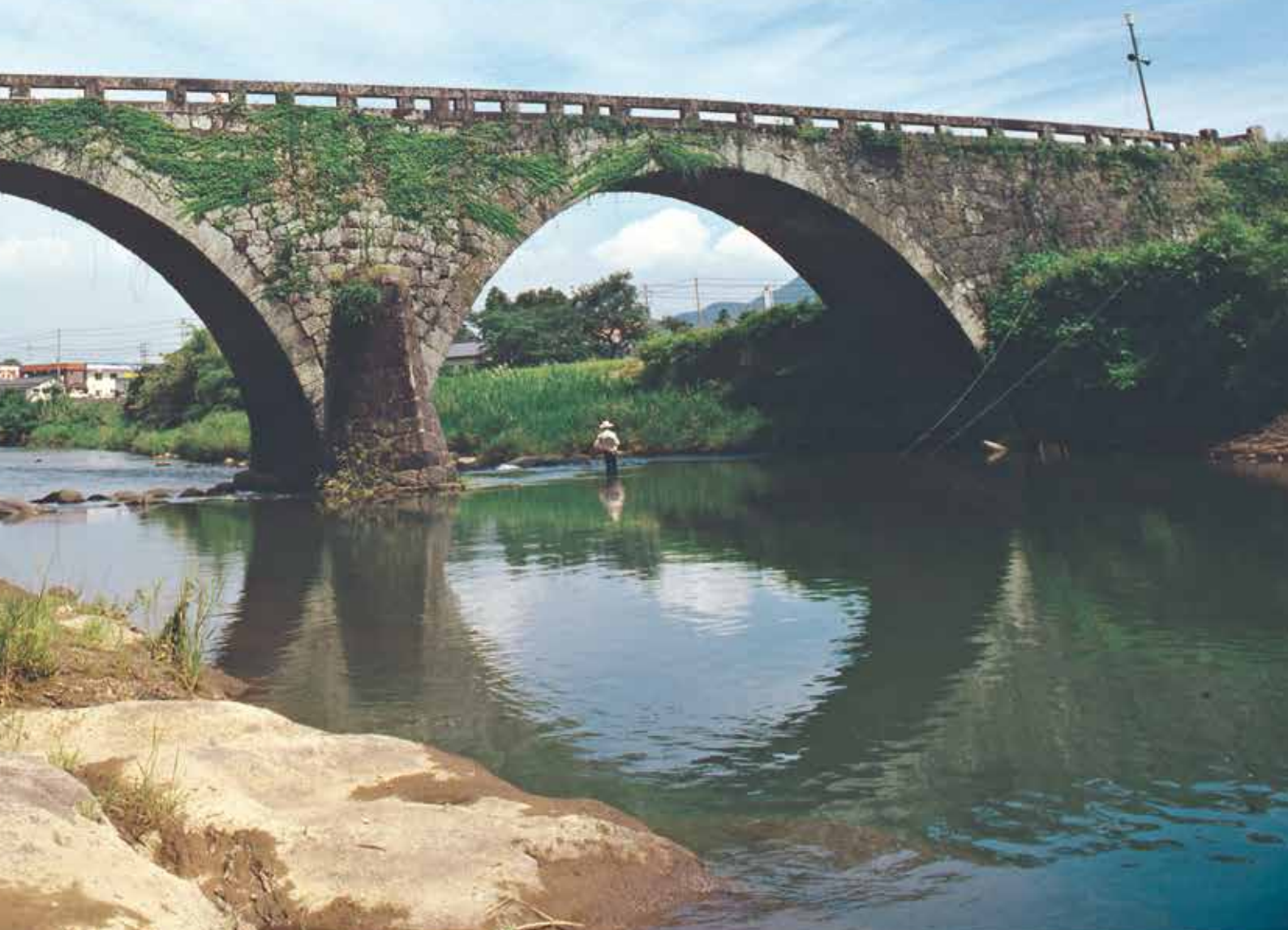
昭和 63 年 5 月 3 日の集中豪雨で流出した御船川目鑑橋（提供／松永写真館）
