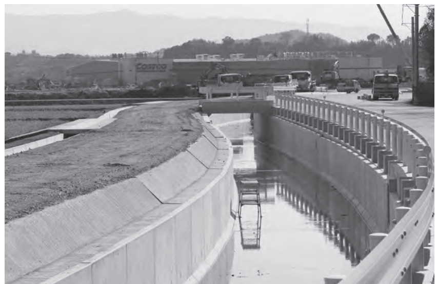
コストコ周辺道路工事の様子
