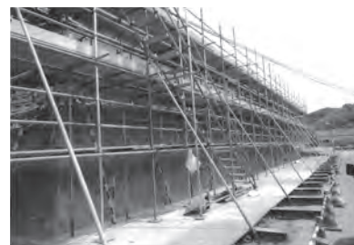
工事現場写真
