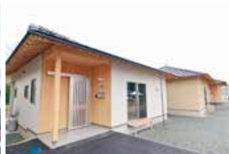
①町営住宅上高野団地 ②令和2年3月4日
