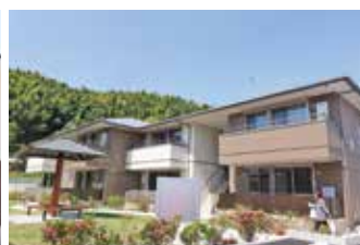
①町営住宅一丁目第2団地 ②平成31年4月19日
