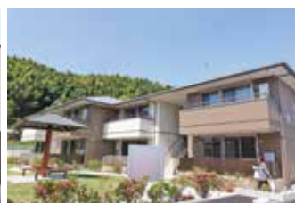
①町営住宅一丁目第2団地 ②平成31年4月19日
