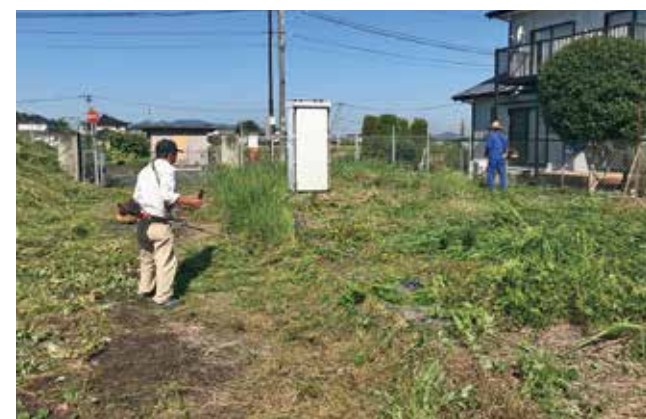
きれいになった水道施設
