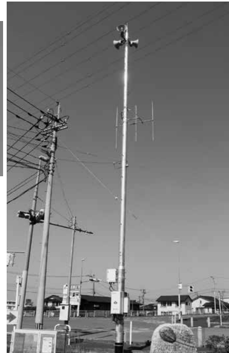
▲南木倉に設置しているスピーカー
