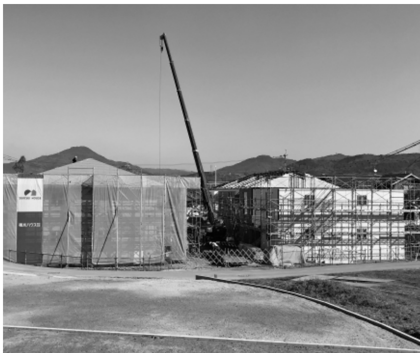
建設が進む災害公営住宅（1丁目Ⅱ期地区）1月17日現在
