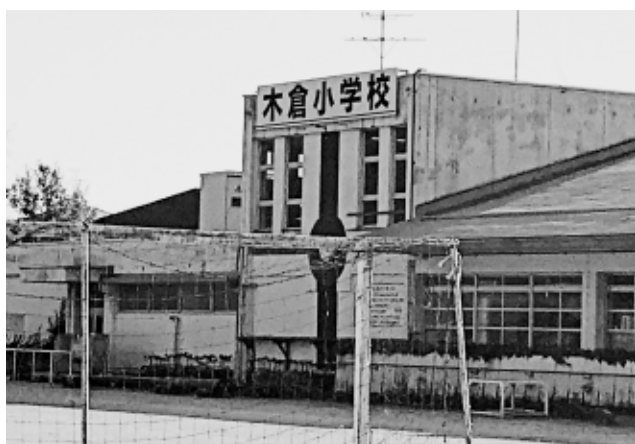
空調設備の設置が待たれる小学校
