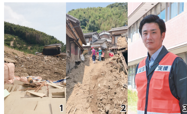
1,2_土砂崩れによって家屋が飲み込まれる(宇和島市) 3_町議会事務局の上村祐史主事
