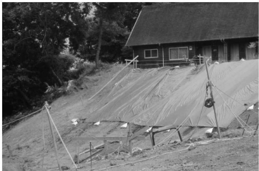
中原団地がけ地の工事現場
