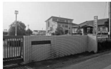
御船浄水センター（下水道処理施設）
