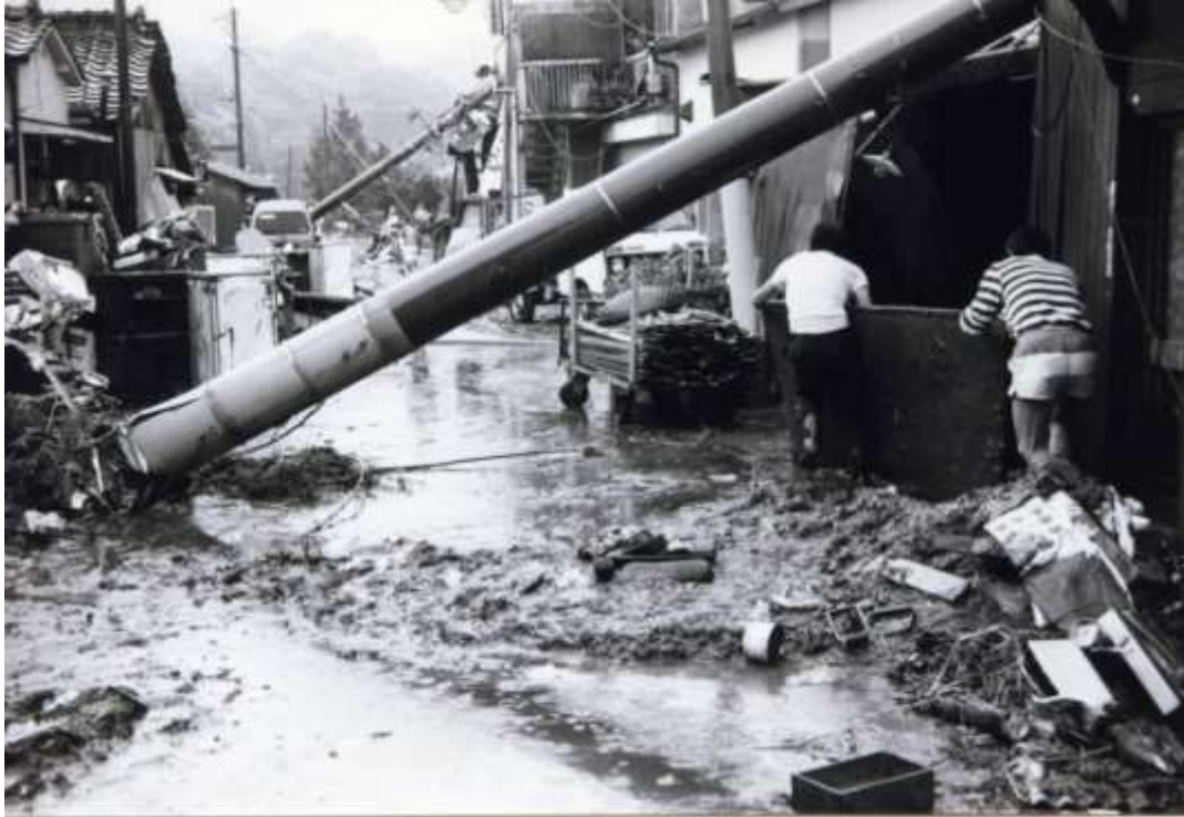
▲無惨に倒れた電柱と泥まみれになった町並
