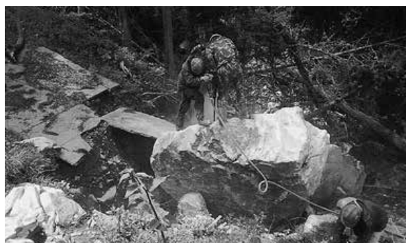
「風神石」の解体様子
