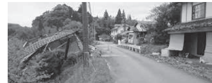
▲家屋が崩れている写真
