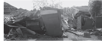
▲屋根が落ち、中の農機具がつぶれている写真
