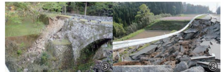
①\_地震後に発生した国道445号の大規模な土砂崩れ（下鶴地区） ②\_崩落した県道田代御船線（餅畑地区） ③\_一部が崩れた県重要文化財の「八勢目鑑橋」（八勢地区）
