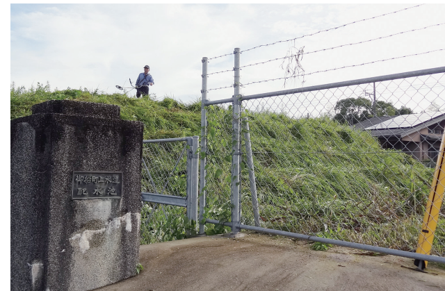
上水道御船配水池の除草作業の様子
