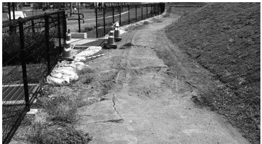
ふれあい広場南側里道（工事予定箇所）
