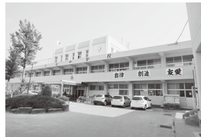
工事が済んだ御船中
