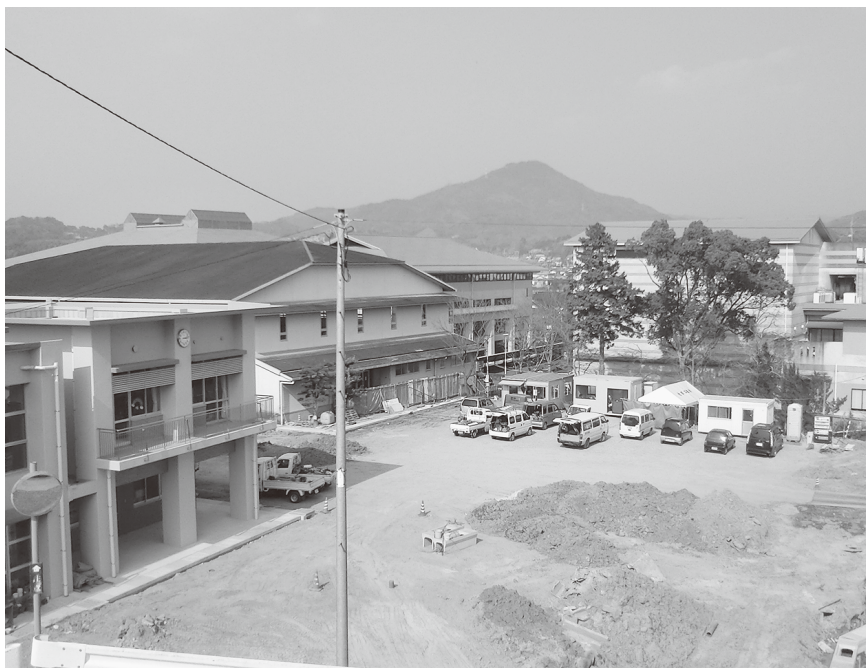
改築が進んでいる御船小学校
