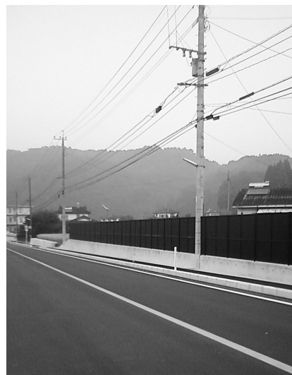
国道路沿いの街灯
