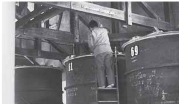
↑昭和20年代後半、五尺桶に代わって酒の貯蔵に使われたホロウビキの大型タンク。直径約240cm、高さ約300cm
