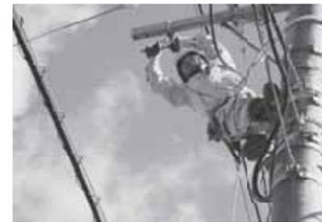
ニシム電子工業(株)(熊本支店)と下請会社3社が急ピッチで工事を進める通信ケーブル架設作業。
