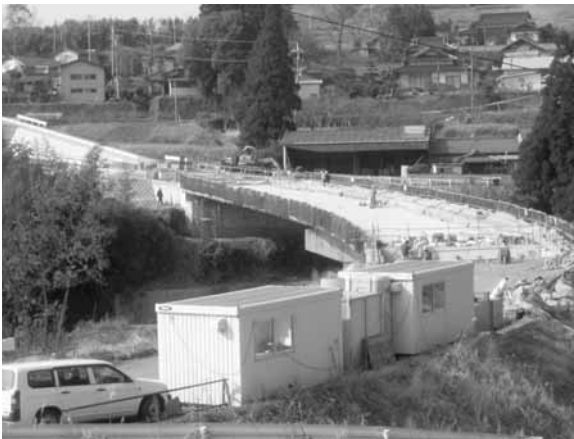
町道北園茶屋元線もこの橋が出来れば完成
