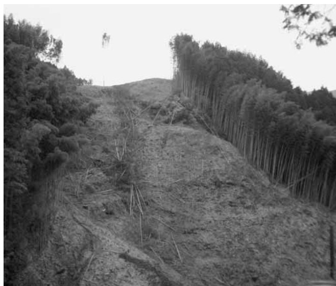
延岡線の建設現場
