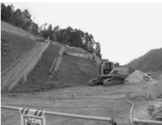
九横道工事現場北田代
