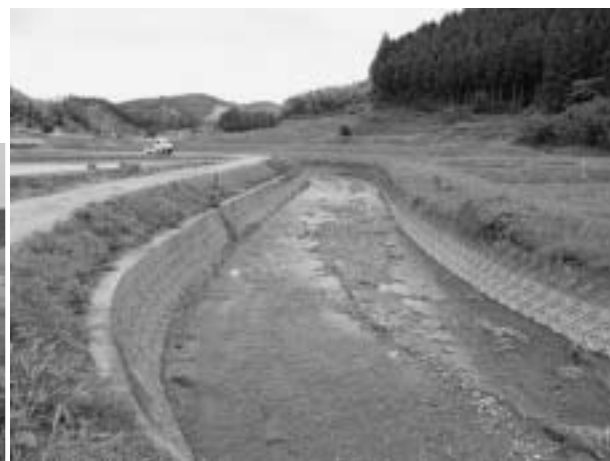
工事後、土砂が取り除かれた川の様子
