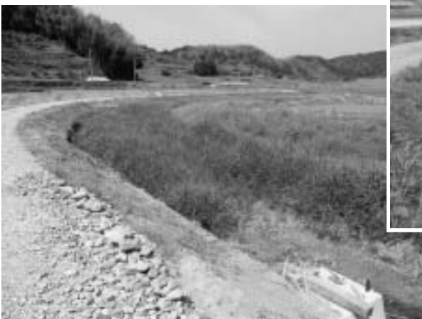
工事前、土砂が堆積している川
