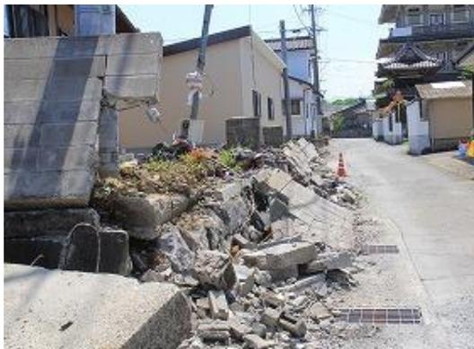
図 ブロック塀の倒壊
