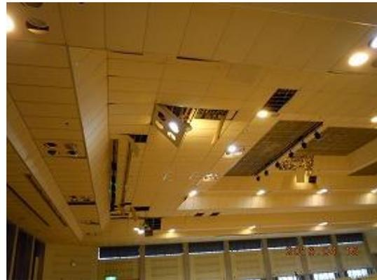
図 スポーツセンター天井材の崩落
