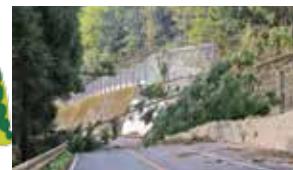
▲台風で土砂や木が道路を縦断
